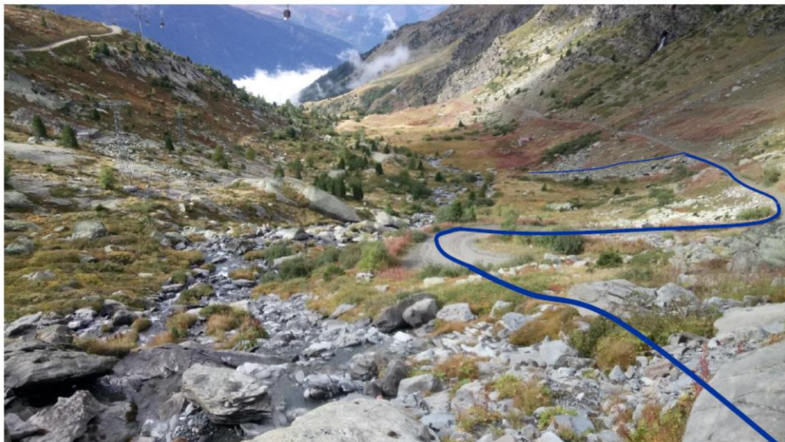
La conduite forcée est majoritairement enterrée sous la piste de l'Arcelin
