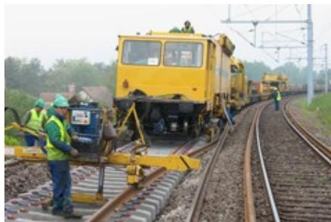
*Longs Rails soudés sur traverses béton*
