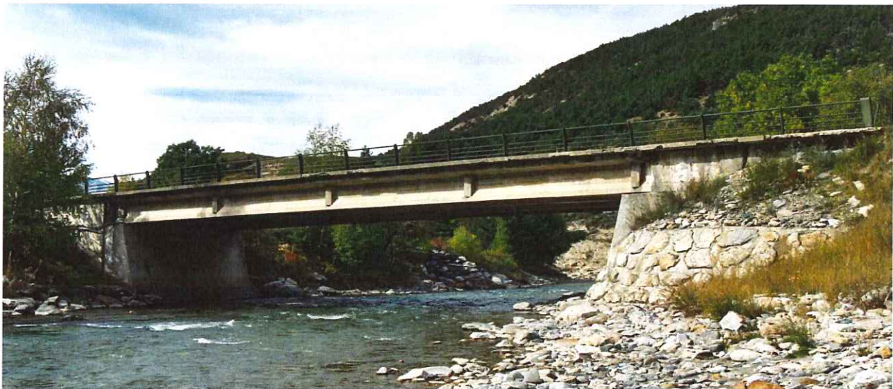
Photo élévation pont du Verney (côté amont)
