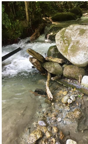
Conduite PEHD traversante sectionnée en amont du pont RD66
