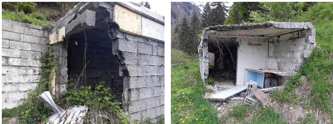
PHOTOS DU VIEUX BATI A DETRUIRE SUR LA ZONE DE PROJET
