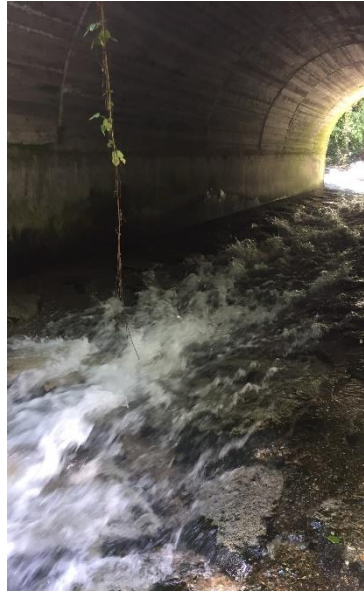
Ouvrage seuil pavé sous le pont RD66
