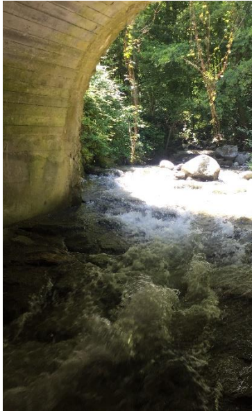
Ouvrage seuil pavé sous le pont RD66
