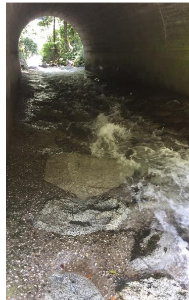
Ouvrage seuil pavé sous le pont RD66
