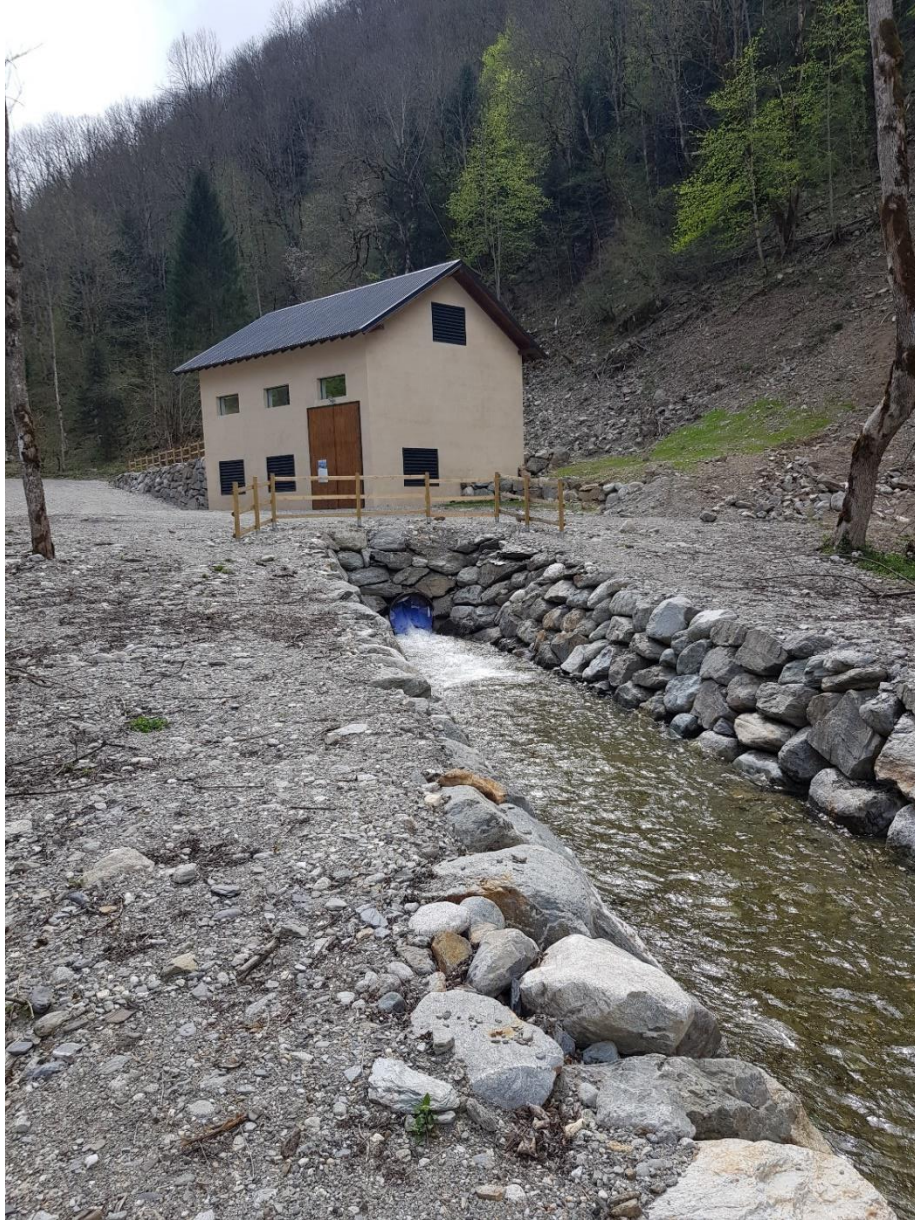
Figure 25 : Bâtiment usine Bonneval
