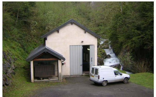
Figure 27 : Bâtiment usine du Lourdios
