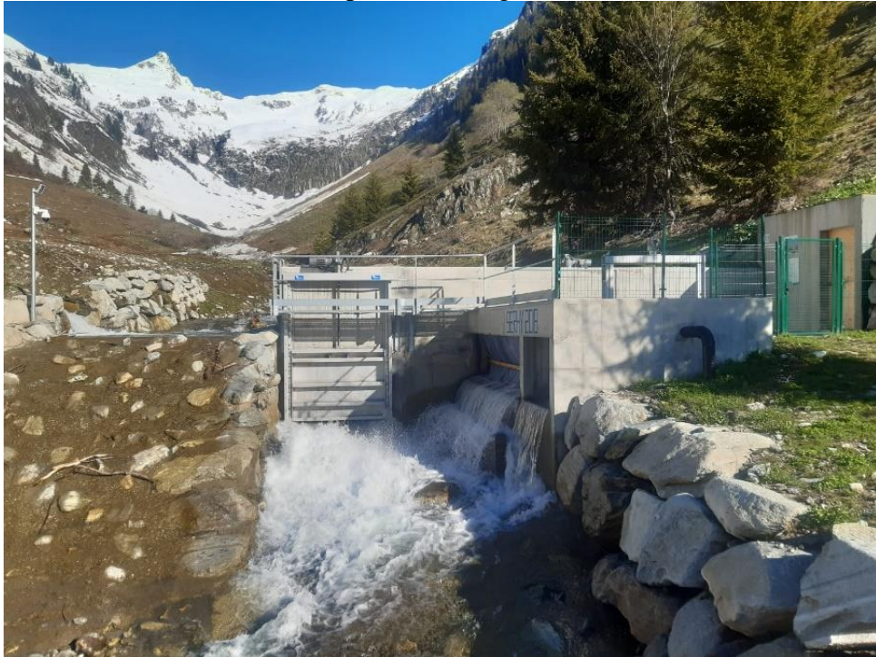
Figure 13 : Exemple d'enrochement bétonné, Bonneval
