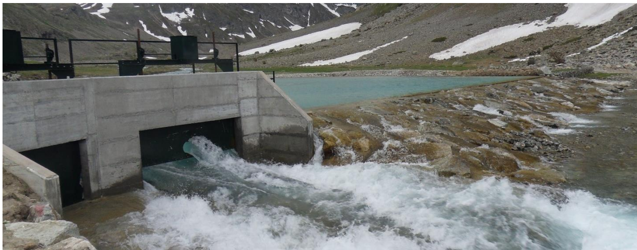
Figure 14 : Exemple de régulation d'une vanne de chasse
