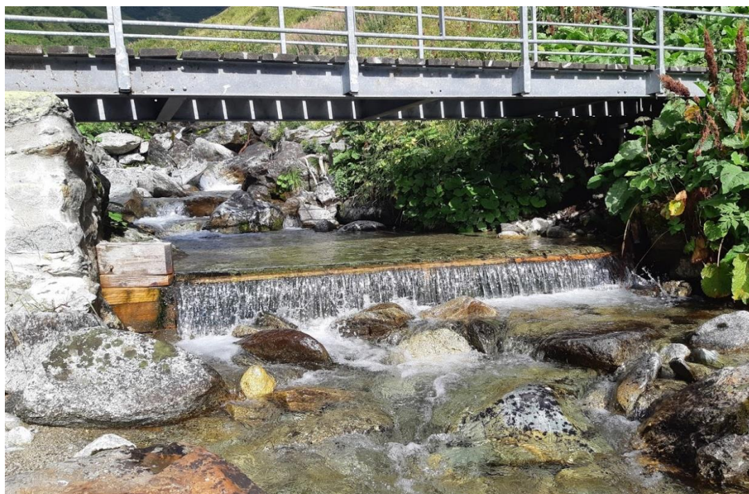
Figure 3 - Seuil de mesure installé en aout 2018
