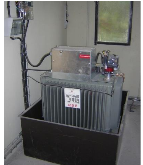
Figure 31 : Transformateur auxiliaire
