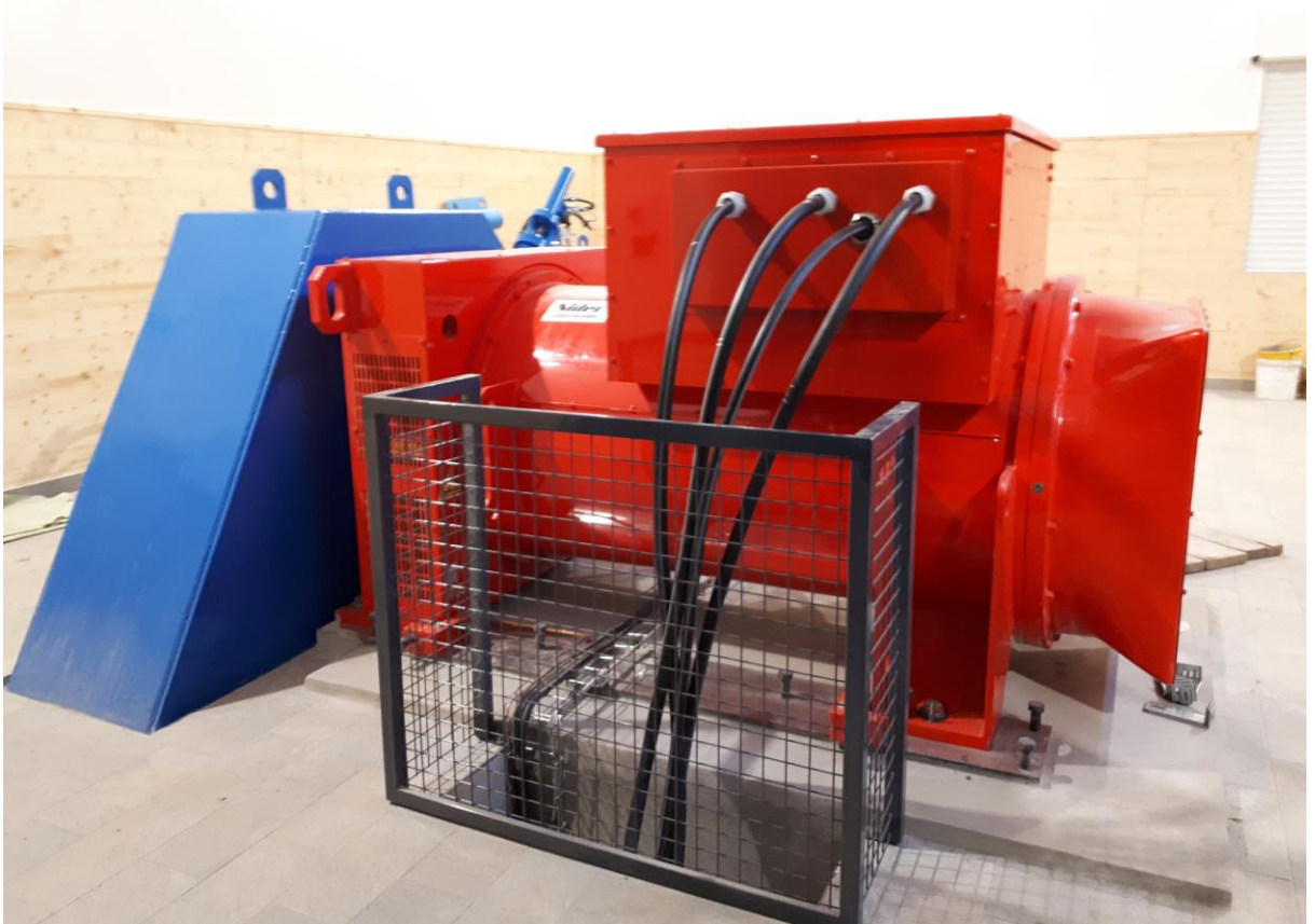
Figure 29 : Le même alternateur monté sur sa turbine
