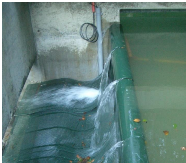
Figure 16 : Exemple de grille autonettoyante
