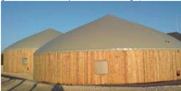
Figure 8 : Exemple de cuves de digestion
