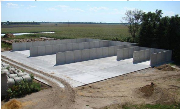
Figure 10 : Silos de stockage
