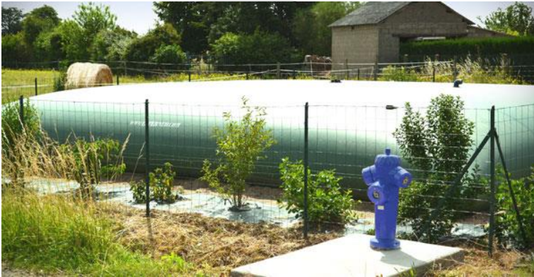
Citerne souple de 120 m 3 équipée d'un Poteau d'Aspiration DN 100
