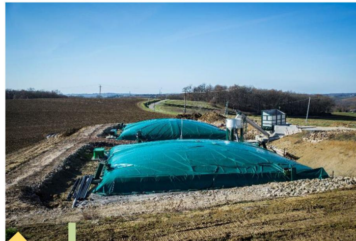
Poches souples méthaniseur 30m 3 et décanteur 60m 3
