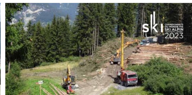
Phases du PPI en cours de travaux
