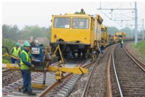
*Longs Rails soudés sur traverses béton*
