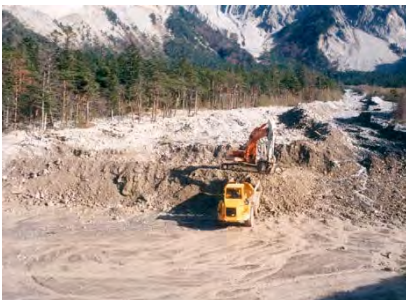
Photo 2.21 : Opération de curage - Tréminis
