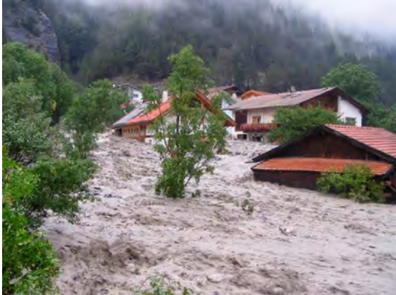
Photo 6.2 : Inondation au Tyrol, 2005 Situation où une évacuation est à prohiber
