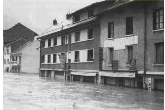
inondation dans les rues de Modane
