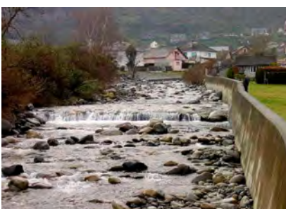
Photo 2.24 : Endiguement d'une rivière torrentielle - Soulom
