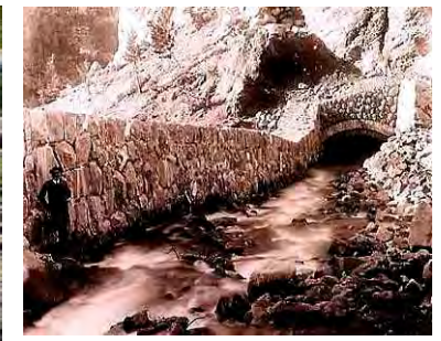
Photo 2.17 : Tunnel de dérivation - Guillestre
