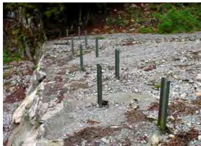
Photo 2.22 : Piège à flottants - Eaux Bonnes
