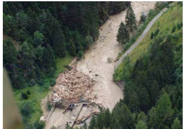
Photo 2.6 : Divagation d'une rivière torrentielle provoquée par l'obstruction d'un pont par des flottants lors des crues d'août 2005 (Autriche)
