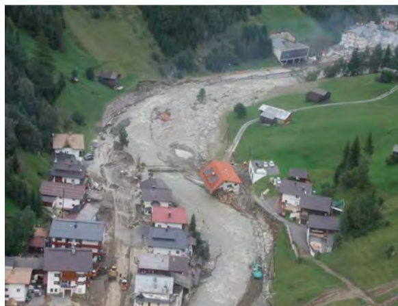
Photo 3.2 : Dégâts provoqués par la crue d'une rivière torrentielle en août 2005 (Autriche)
