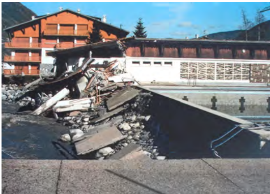
Photo 6.10 : Saint-Lary 1982, dégâts à la piscine
