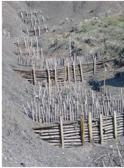
Photo 2.13 : Correction de ravins à l'aide de palissades et de boutures - Draix
