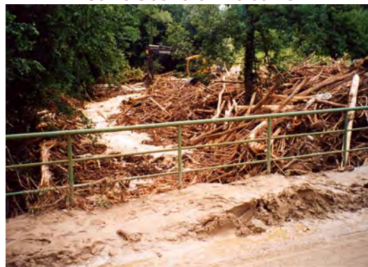
Photos 2.7 : Formation d'embâcles au droit d'un pont Saint-Geoire-en-Valdaine
