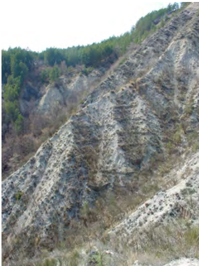
Photo 2.12 : Correction de versant à l'aide de banquettes grillagées – La Motte du Caire
