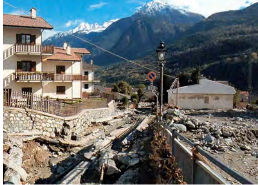
Photo 6.9 : Val d'Aoste 2000, destruction des réseaux
