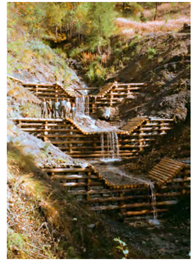
Photo 2.14 : Correction de ravins à l'aide de seuils en bois – Le Monetier les Bains
