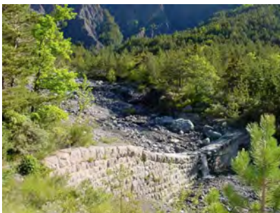
Photo 2.15 : Barrage en maçonnerie – Villeneuve d'Entraunes
