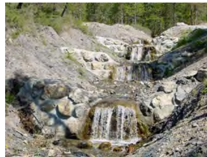
Photo 2.16 : Barrages en enrochements - Embrun
