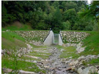
Photo 2.19 : Plage de dépôt - Verdun sur Ariège
