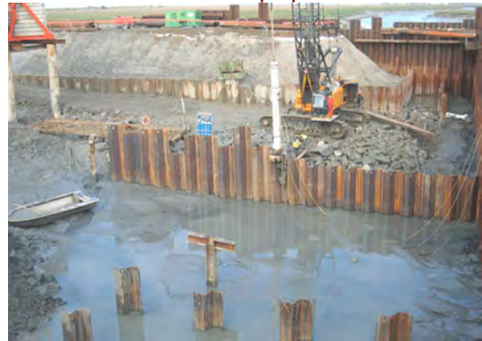
Photo 6.13 : Rideau de palplanches en acier
