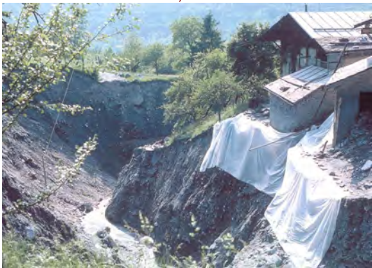
Photos 4.5, 4.6 : Affouillements Torrent de la Ravoire, 1981
