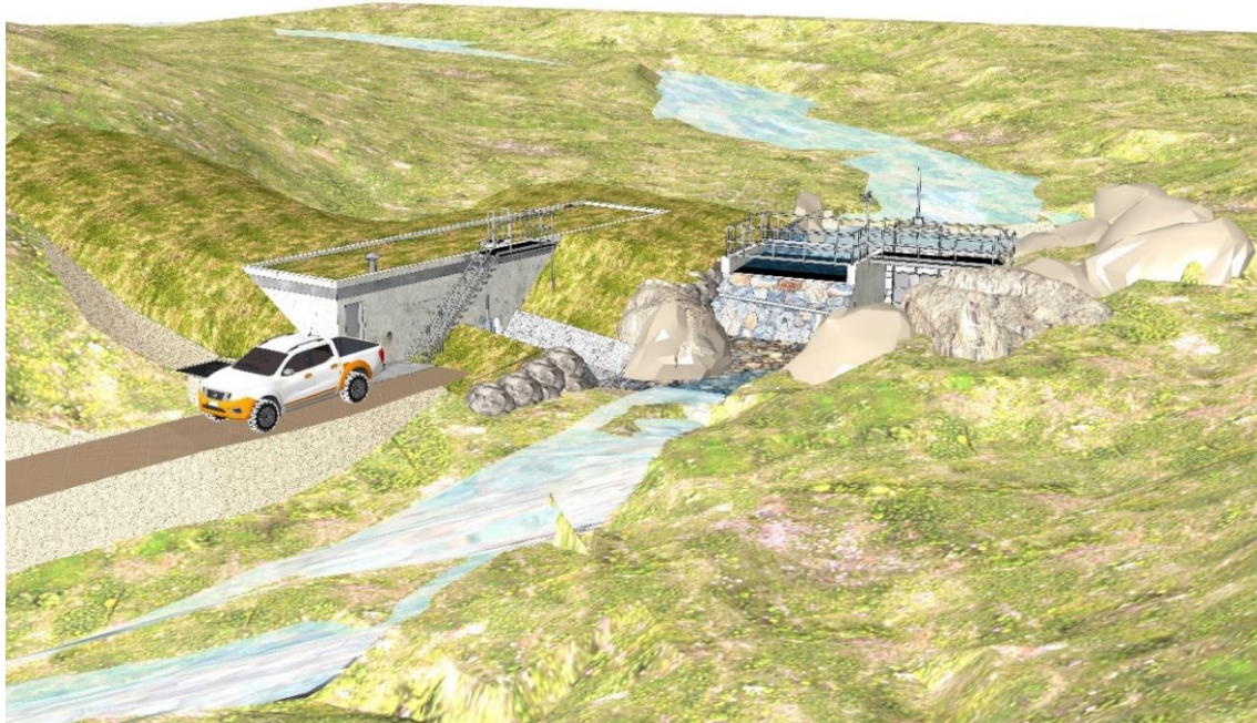
Projet retenu : une adaptation aux enjeux écologiques et paysagers (toit terrasse, piste suivant un bras mort du cours d'eau, prise d'eau hors enjeux plantes protégée), avec mesures spécifiques à mettre en œuvre pour l'intégration des terrassements
