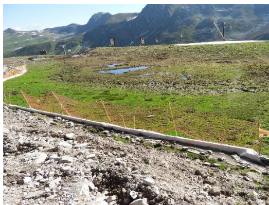
Géotextile à la mise en place
