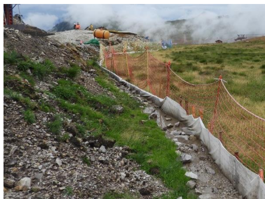
Géotextile à la fin des travaux
