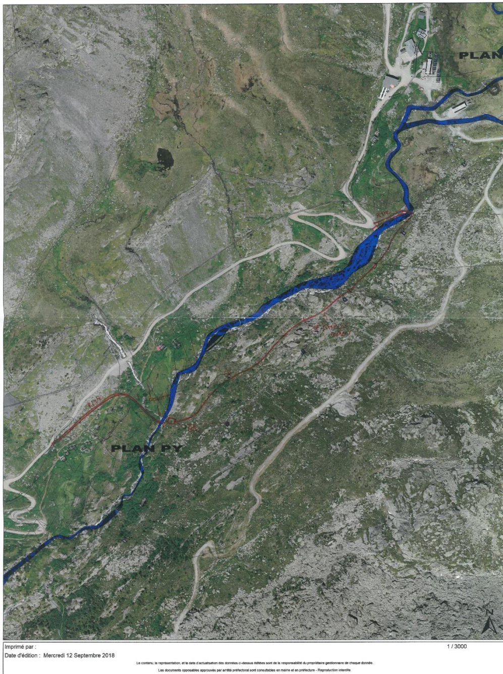
Eté 2018, premier projet : passage en rive gauche avec accès de maintenance à l'usine par la rive gauche (source Synergie Maurienne)
