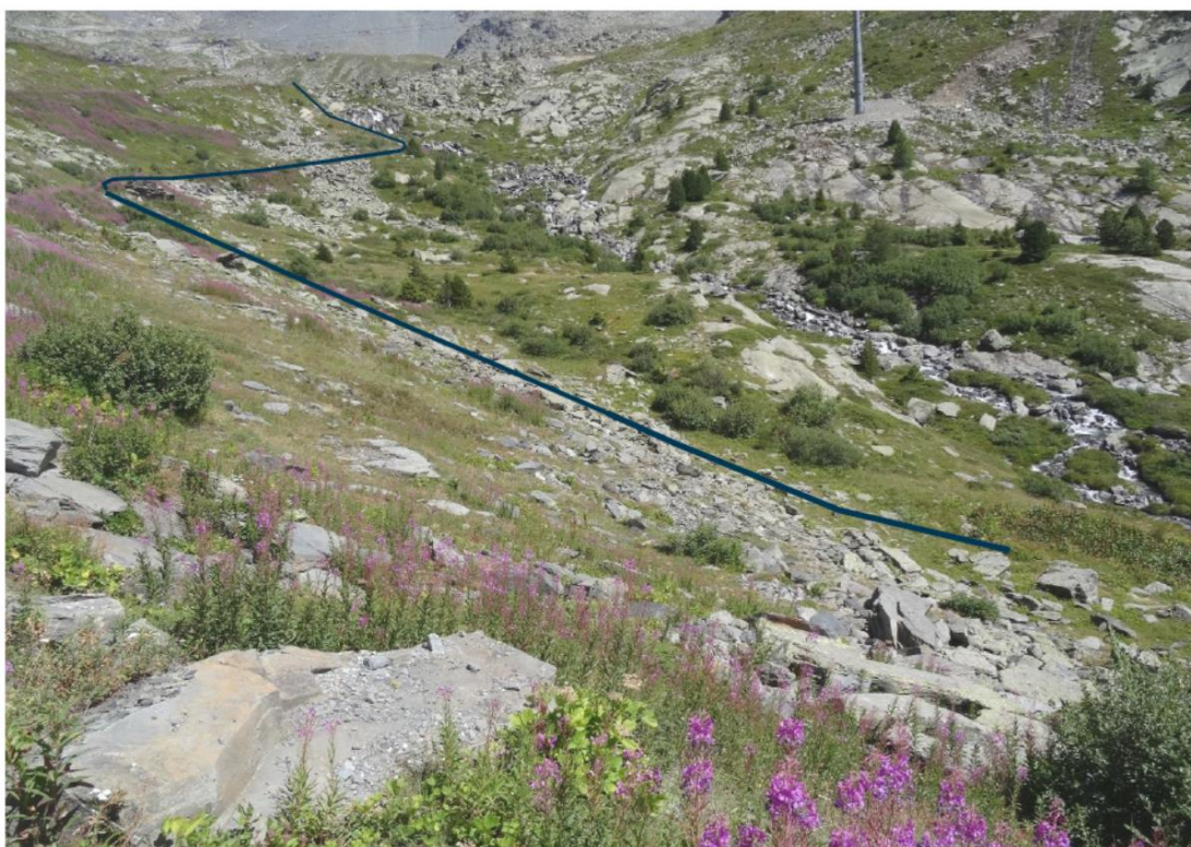
Vue d'ensemble à l'arrivée de la conduite sur le site de l'usine de production (à l'aval de la piste)
