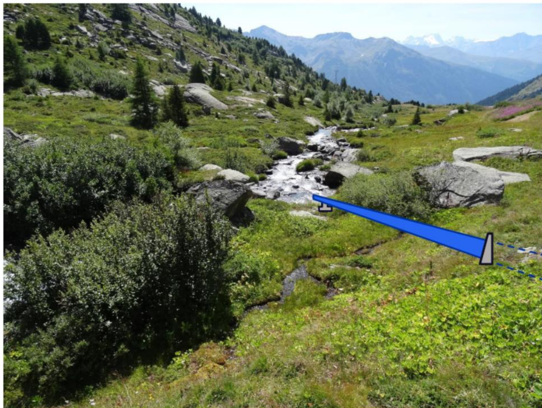
Vue du site avec la conduite de restitution (en bleu), en aérien posée sur des dalles déjà en place
