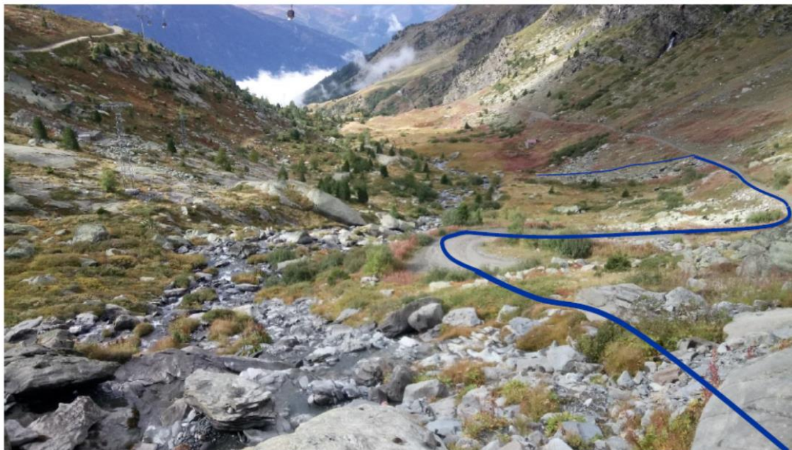
Vue d'ensemble de la partie aval de la canalisation sous la piste
