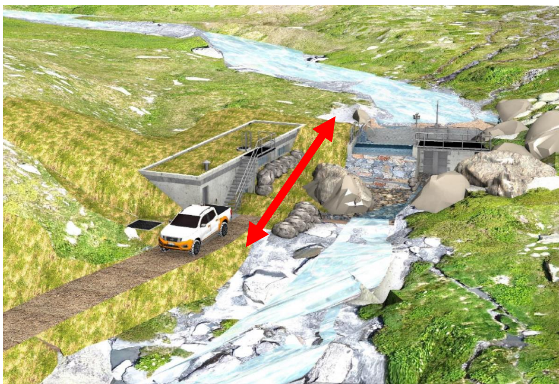
Vue 3D de la prise d'eau (Alp'Etudes) avec accès pour la Crossope aquatique (flèche rouge)
