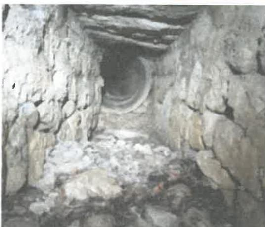
Figure 2: Photo de la buse amont depuis l'ouvrage maçonné
