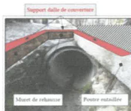
Figure 3 : Entonnement des Vauthiers amont : situation actuelle (gauche) et travaux prévus (droite)
