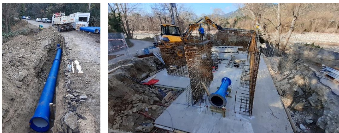
Figure 1: Photographies du chantier de la centrale hydroélectrique de la Lentilla
