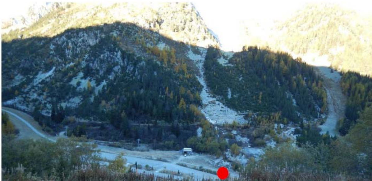
Vue du Pré Saint Esprit (gare de départ au niveau du point rouge)
