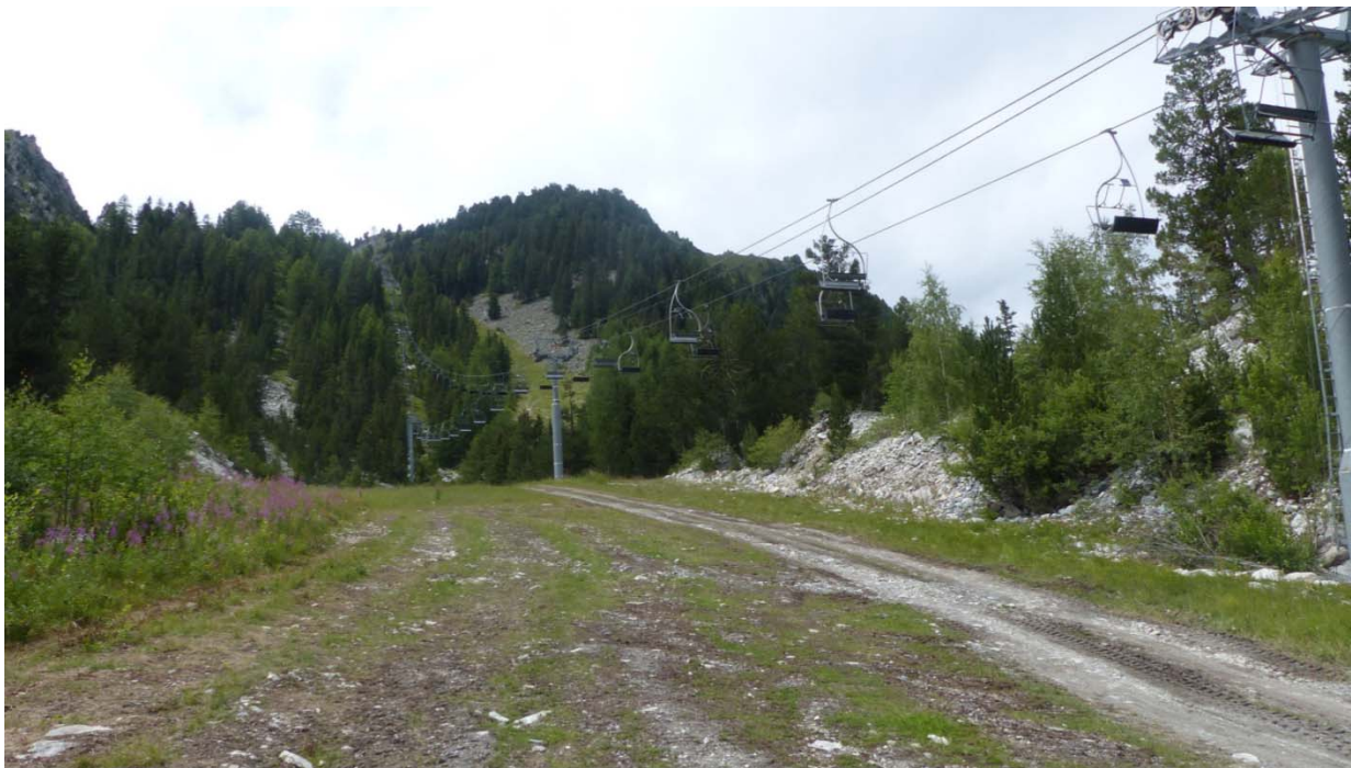
Vue hivernale et estivale sur la ligne du télésiège, partie basse
