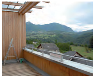
Façade sud - balcon
