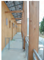
Façade nord - coursive
