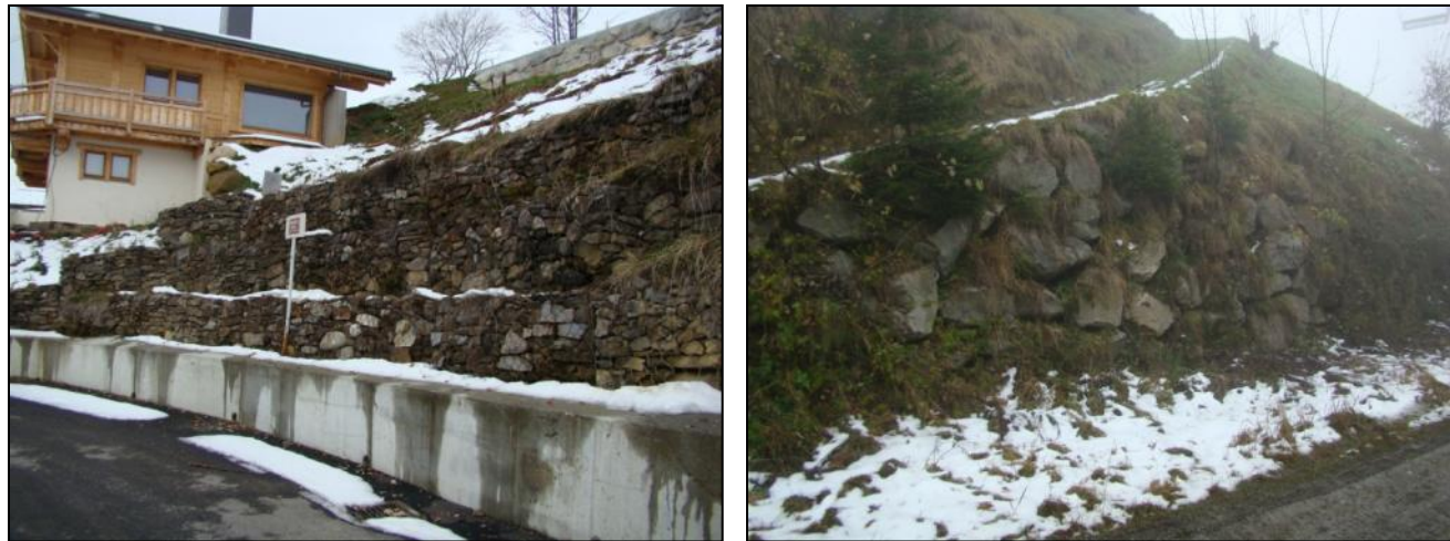
Figure 4 : Gabions dans le hameau de la Raje (à gauche) et enrochements secs le long de la piste du Chosal (à droite) [Source : IMS RN ]
