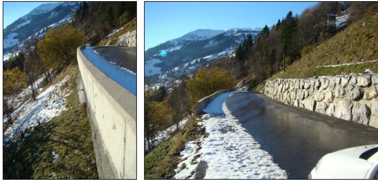
Figure 7 : Paroi clouée et enrochement bétonné au Planay, le long de la route menant au Col du Joly [Source : IMS RN ]
