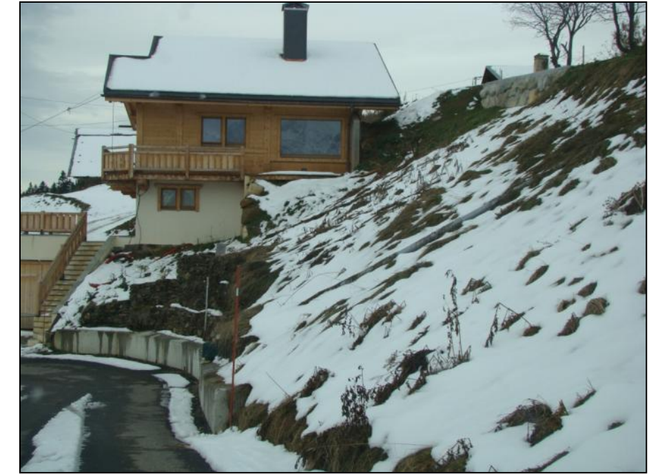
Figure 12 : Confortements (enrochement bétonné en amont et gabions en aval) dans le hameau de la Raje [Source : IMS RN ]
