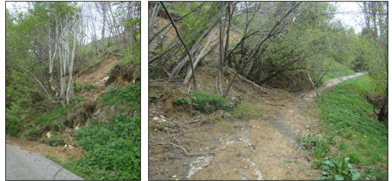
Figure 31 : Pied du glissement sur la route en contrebas [Source : IMS RN ]
