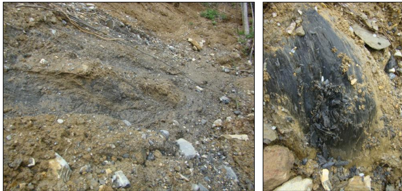
Figure 30 : Substratum schisteux altéré visible au niveau du plan de glissement [Source : IMS RN ]
