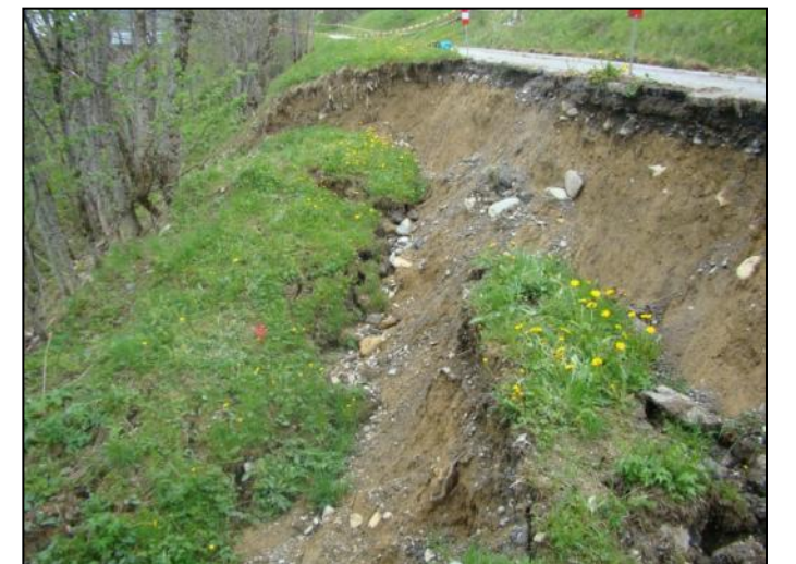
Figure 28 : Niche d'arrachement secondaire du glissement [Source : IMS RN ]
