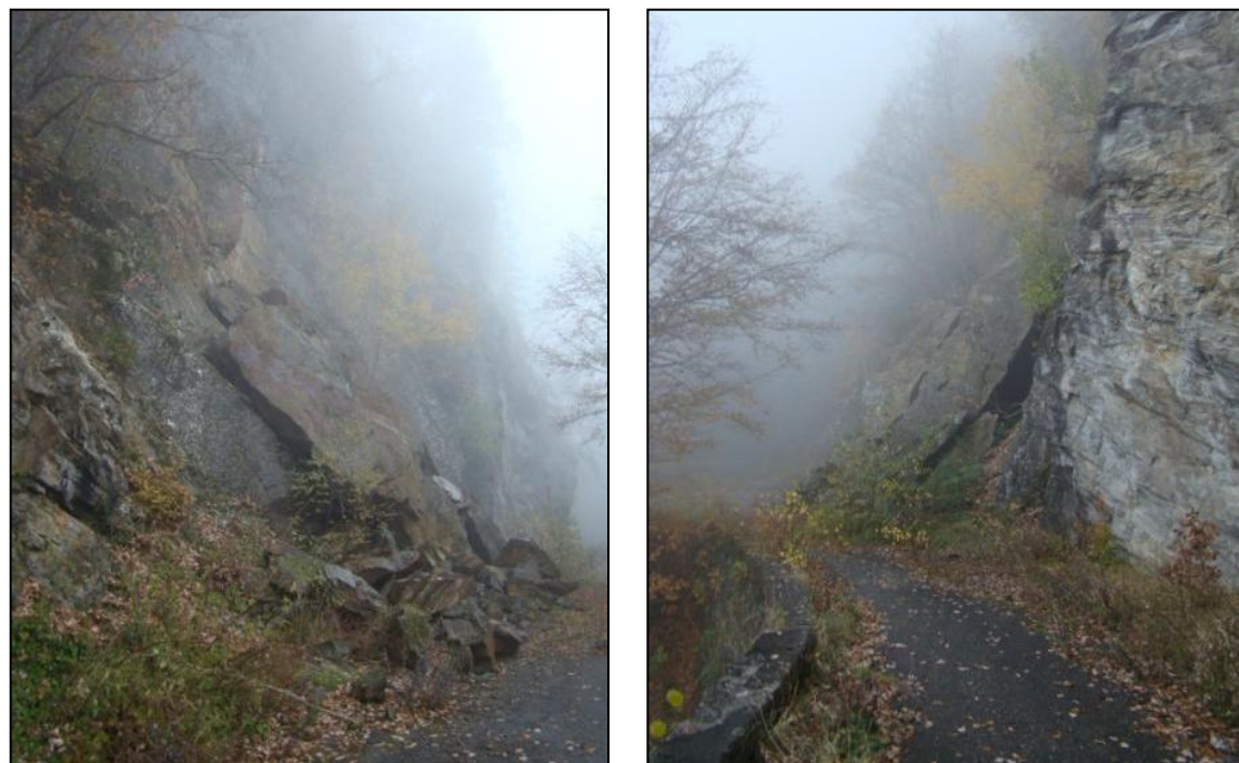
Figure 1 : Eboulement de 2006 sur la RD 218 E vers Portettaz [Source : IMS RN ]
