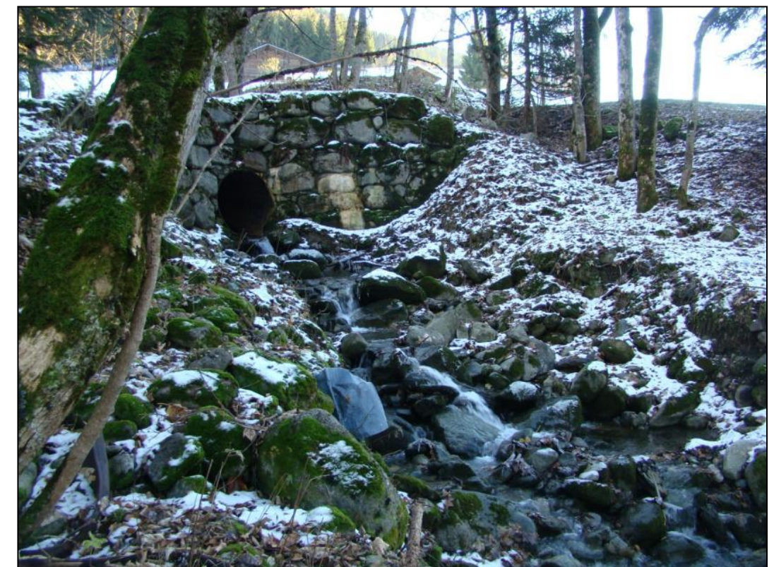
Figure 23 : Ruisseau de l'Alpettaz, buse de 1,50 m [Source : IMS RN ]
