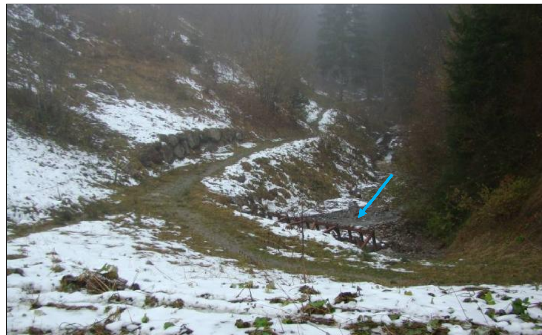
Figure 11 : Nant de Chosal en amont de la scierie au niveau de la piste de ski [Source : IMS RN ]
