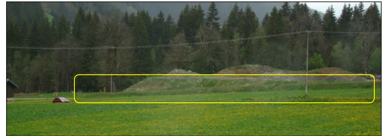
Figure 22 : Digue de terre à l'Infernet [Source : IMS RN ]
