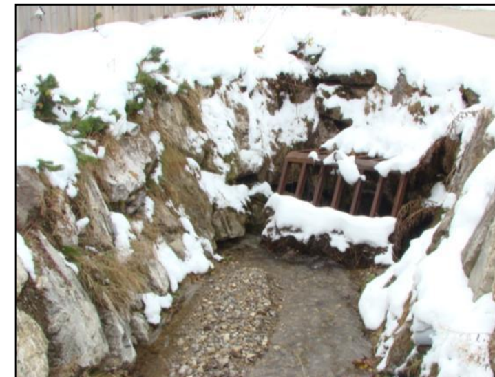
Figure 4 : Cours d'eau avec le seuil, buses et grille [Source : IMS RN ]
