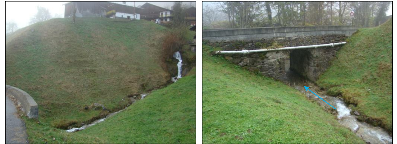
Figure 10 : Torrent aux Côtes avec un pont assez large [Source : IMS RN ]
