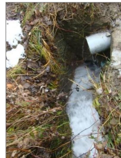
Figure 19 : Buse sous-dimensionnée [Source : IMS RN ]
