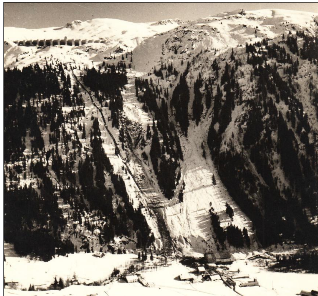
Figure 15 : Photo de l'avalanche de 1953 [Source : RTM]
