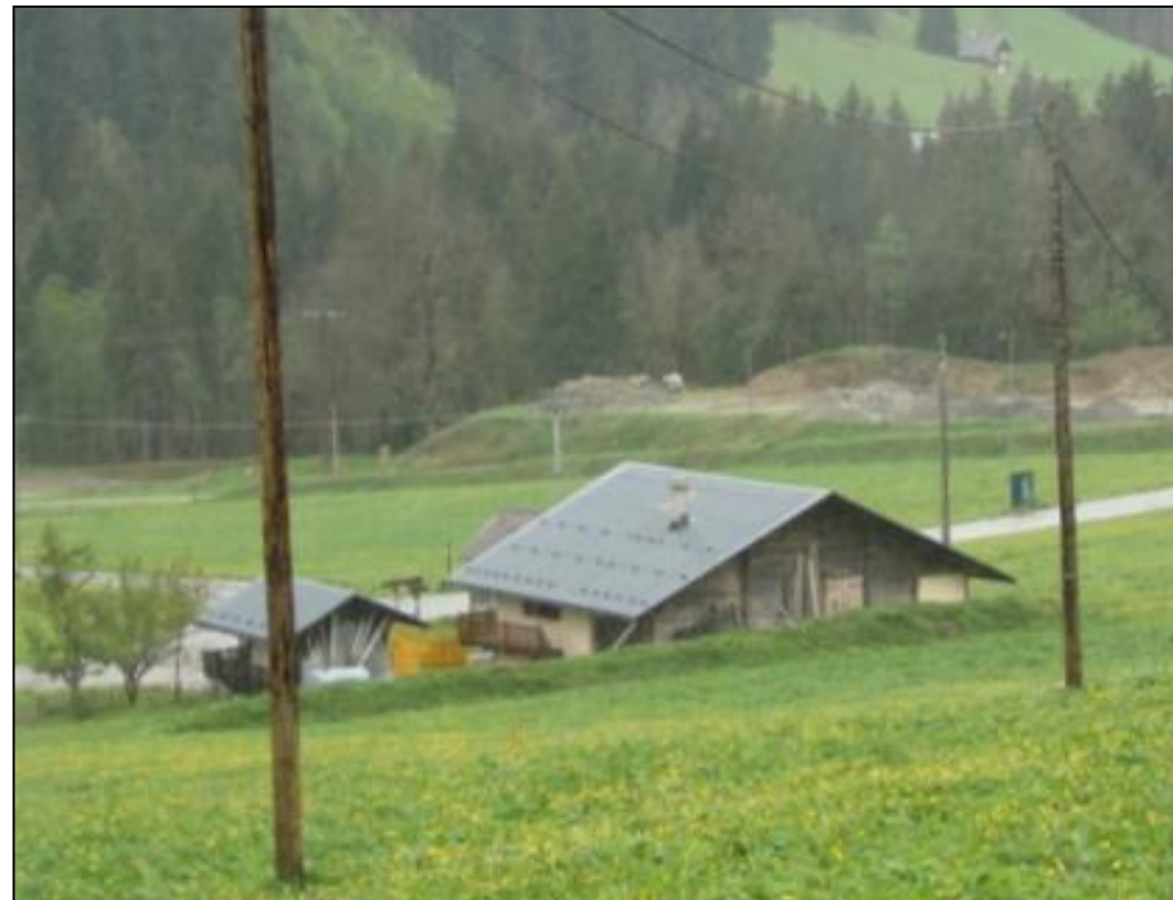
Figure 12 : Muret-digue située juste en amont de l'habitation [Source : IMS RN ]
