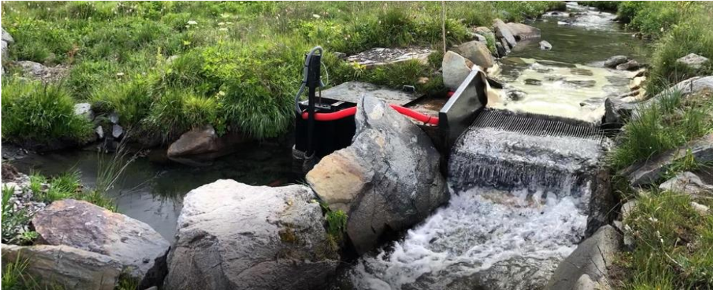
Ouvrage au fil de l'eau pour le captage
