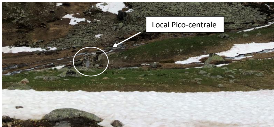
Local de la pico-centrale semi-enterrée et façade en pierre
