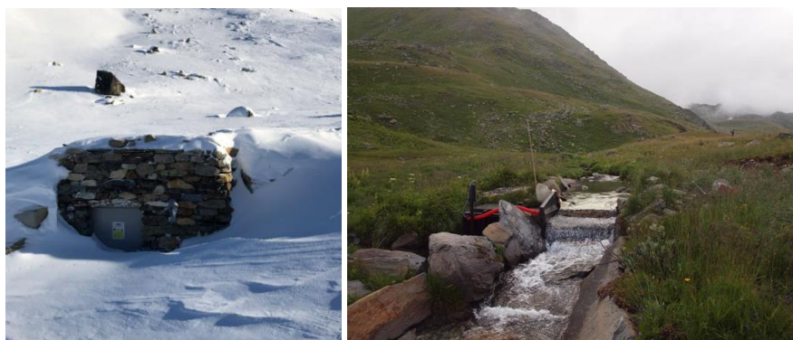
Local de la pico-centrale sous la neige / Ouvrage du captage
