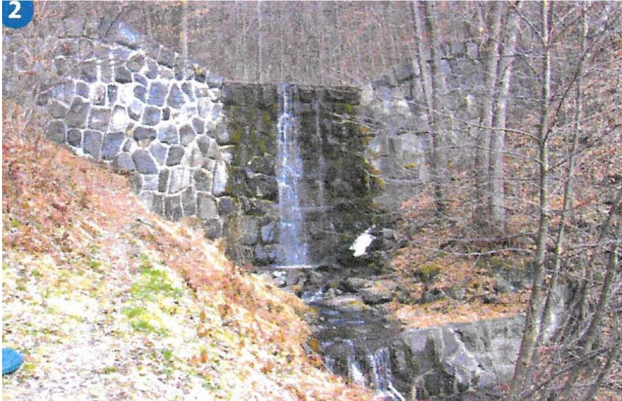
RTM73 04/2006 Grand Barrage du hameau des Teppes
