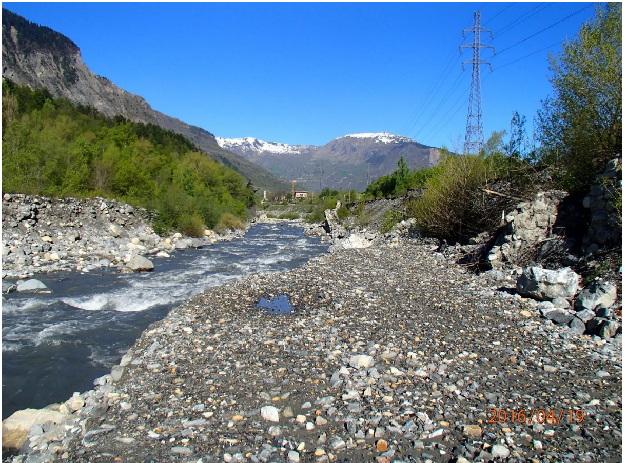
Secteur de l'Arc à remettre en état entre l'ancien seuil du Bochet et l'usine FERROPEM (confortement des rives, élargissement du lit et création d'un seuil)
