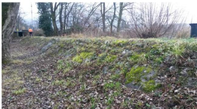
*Photo 1 : Perré en pierres de taille - aval rive droite. Banquette végétalisée*
