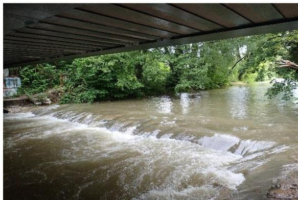
*Photo 4: Seuil amont sous le pont ferroviaire*
