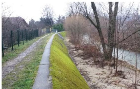
*Photo 2 : Parement béton - rive gauche. Atterrissement sableux sur banquette végétalisée*
