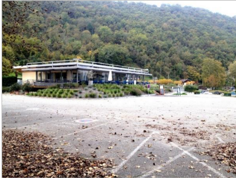
Figure 7 : Photo de l'esplanade devant le restaurant en enrobé
